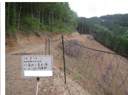
防護柵施業完了
