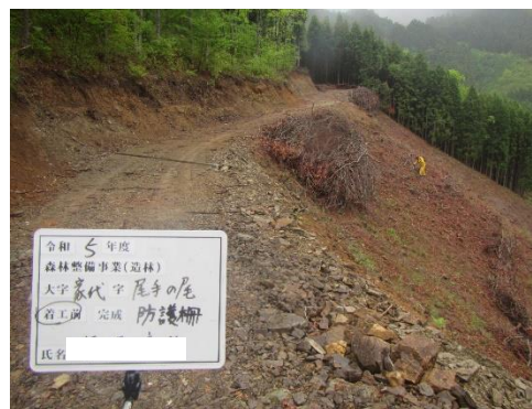
防護柵施業前
