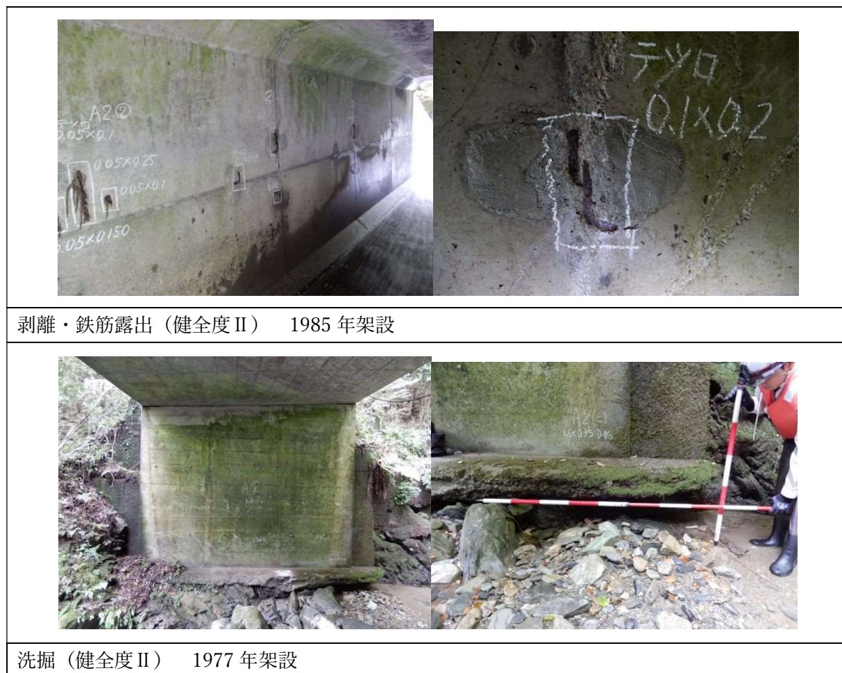
図 5 損傷状況
