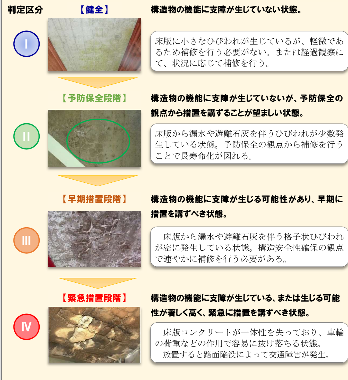
図 13 橋の健全度の事例
