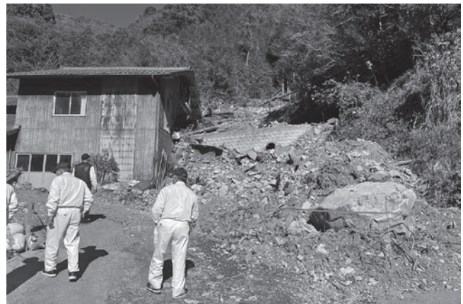
災害調査の様子
