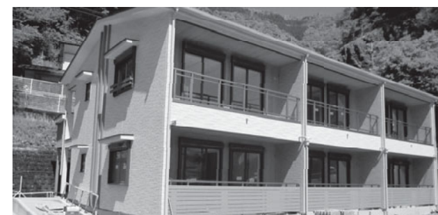
建設中の公営住宅砂田の元団地(第2団地)
