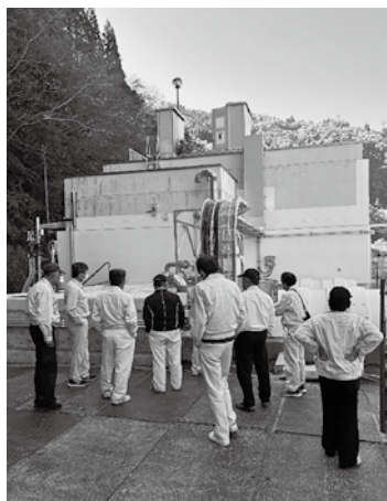
公共下水道諸塚浄化センター
